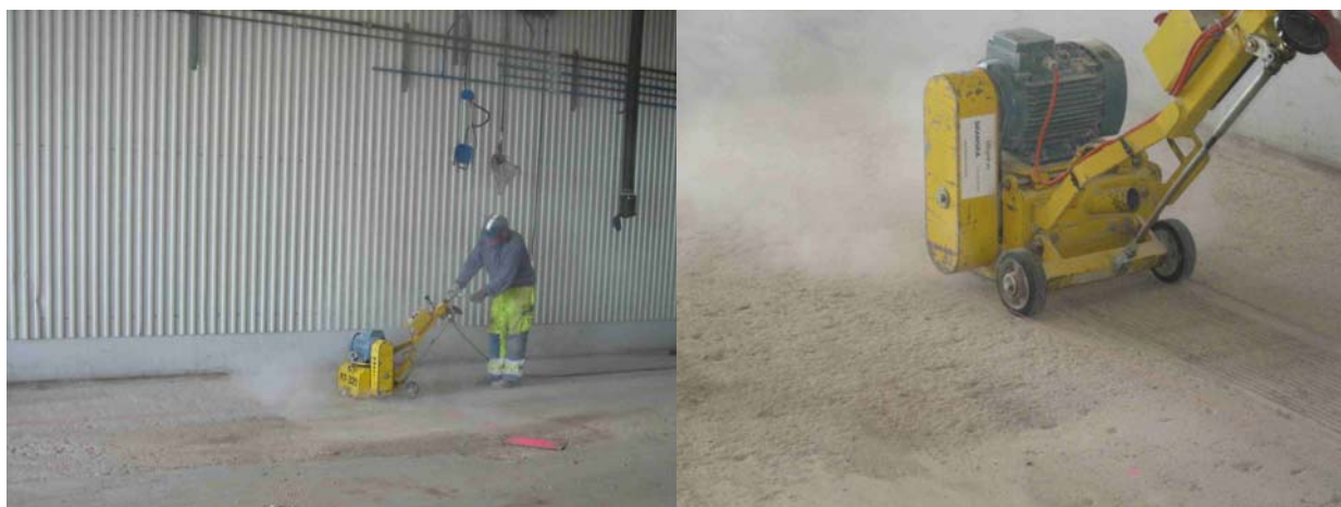
Figur 7:2. Fräsning av ytan med mindre handhållen fräs.
