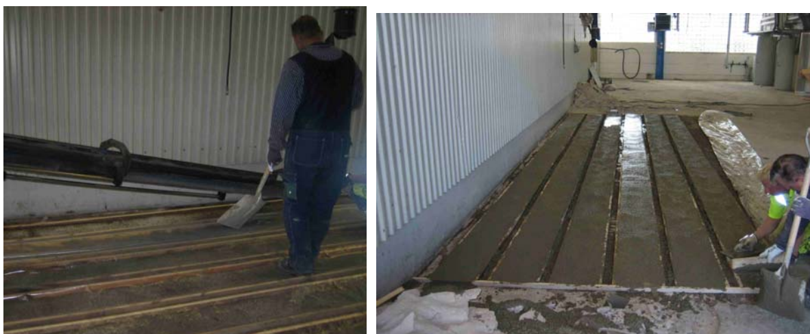
Figur 7:5. Gjutning av de långsmala ytorna.
