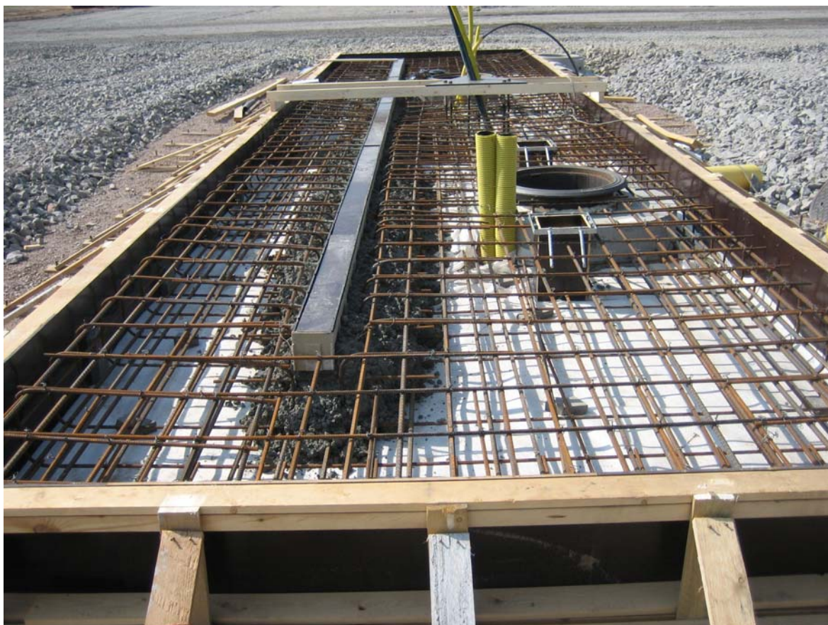
Figur 8:3. Platta innan gjutning
