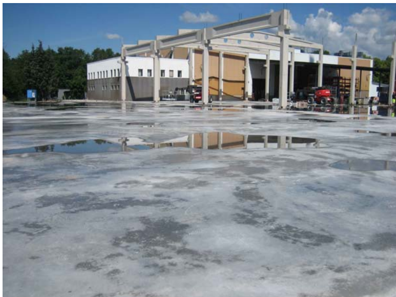
Figur 8:7 Den färdiggjutna plattan 5 dagar efter gjutning.
