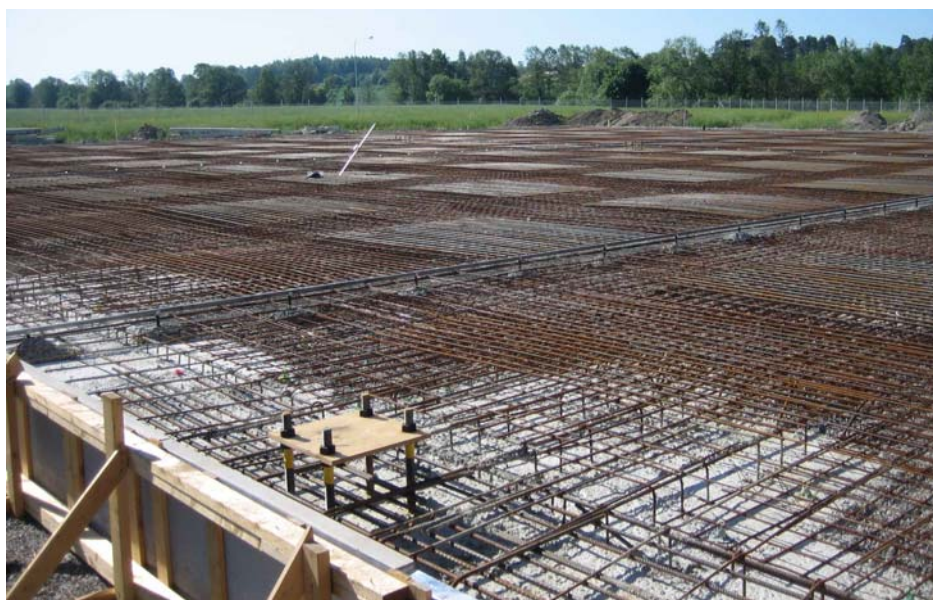
Figur 8:6. Armerad platta med tilläggsarmering över pålhuvuden.
